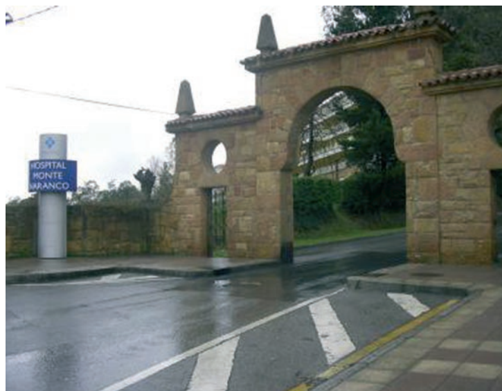
Puerta de acceso al Hospital Monte Naranco
